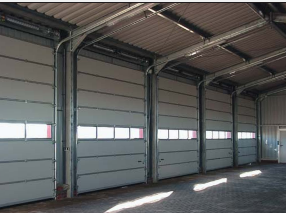
Takskjutport SW med normalbeslag anpassade till taklutningen.
