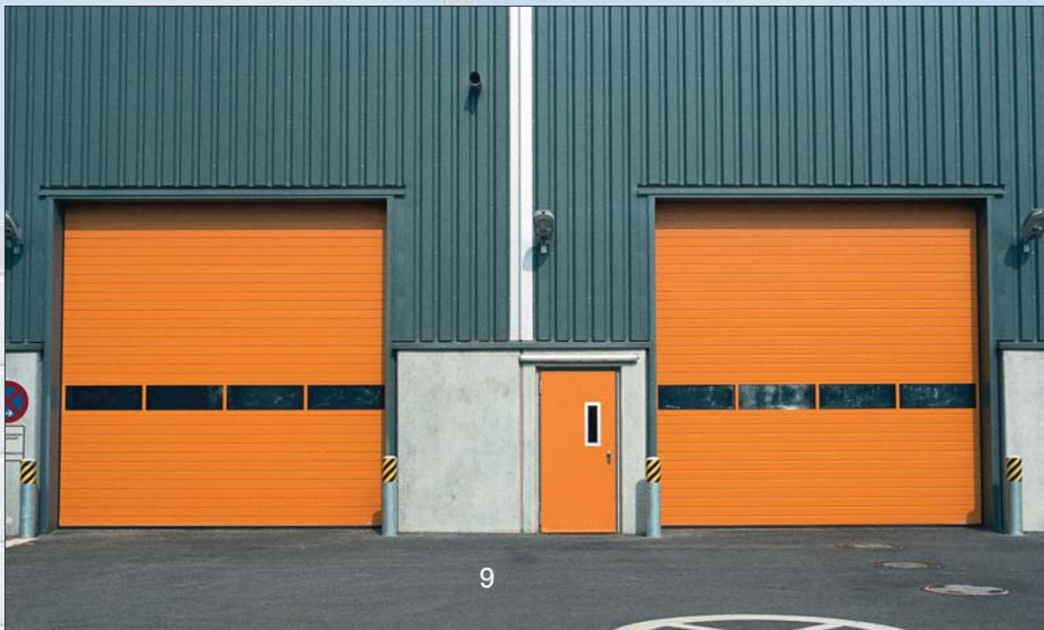
Talskjutport SW, färgad yta och fönsterband.
