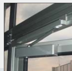
Genomgångsdörr med dörrstängare med glidskena.
