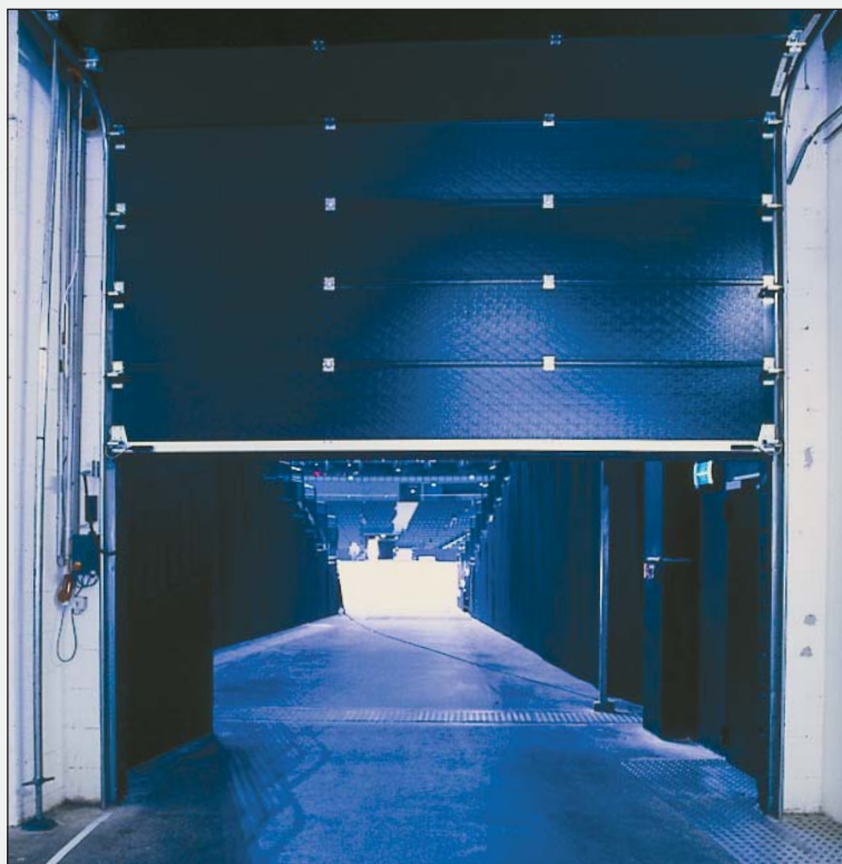
Takskjutport SW, använd som nödutgång.
